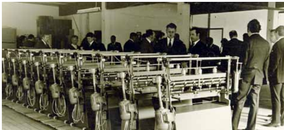
Die ersten grösseren Dübelbohrmaschinen werden vorgestellt.
