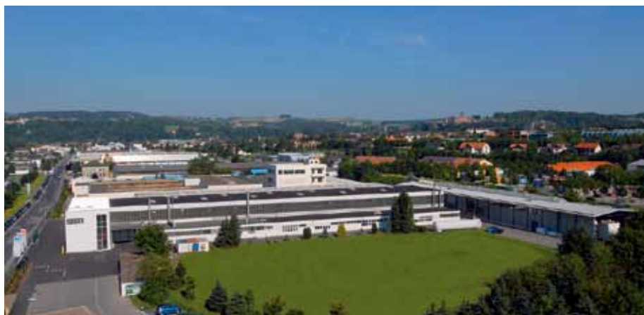
Neue Infrastruktur in Kronach DE.
