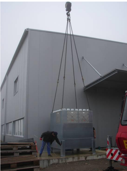
Platzierung des Filter-Grundelement
