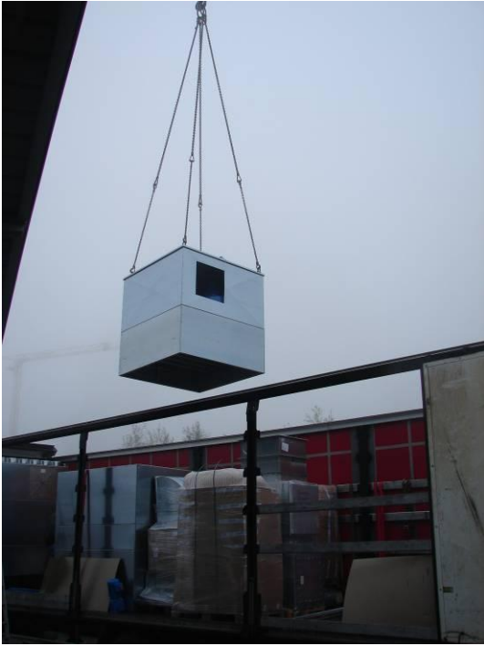
Direkt vom LKW in 3 Teilen zusammengebaut
