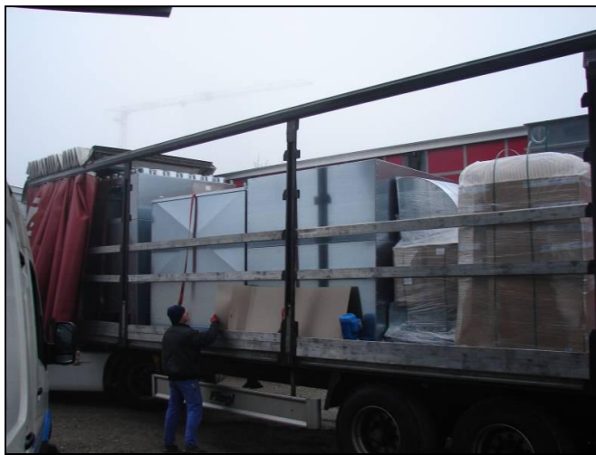
Anlieferung der Bauteile
